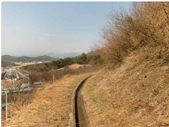
1소단 배수로 전경
