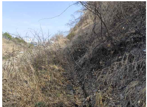
2소단 배수로 전경
