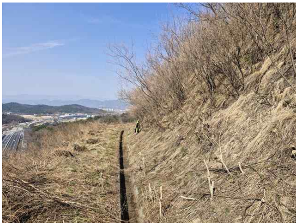
3소단 배수로 전경
